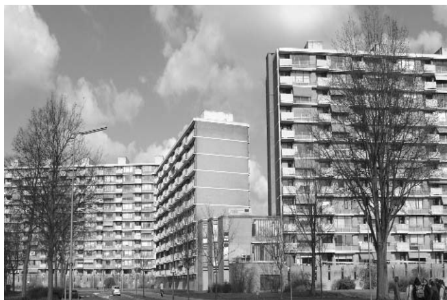
Zonne- en Eemstein voor de renovatie
