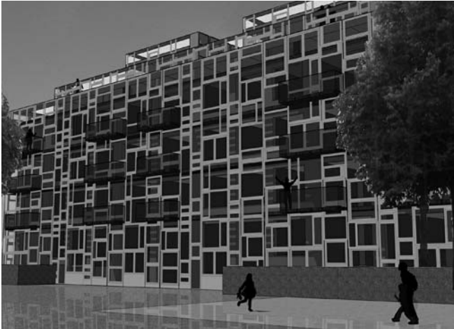
Gevel aanzicht na plaatsen van hergebruikte kozijnen als klimaatgevel
