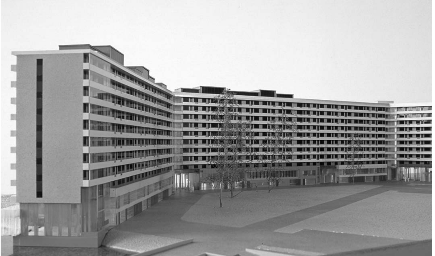
De Grubbehoef Bijlmermeer. Herprogrammering van de onderste twee bouwlagen, bescheiden verbetering van de woningen, CASA 2006
