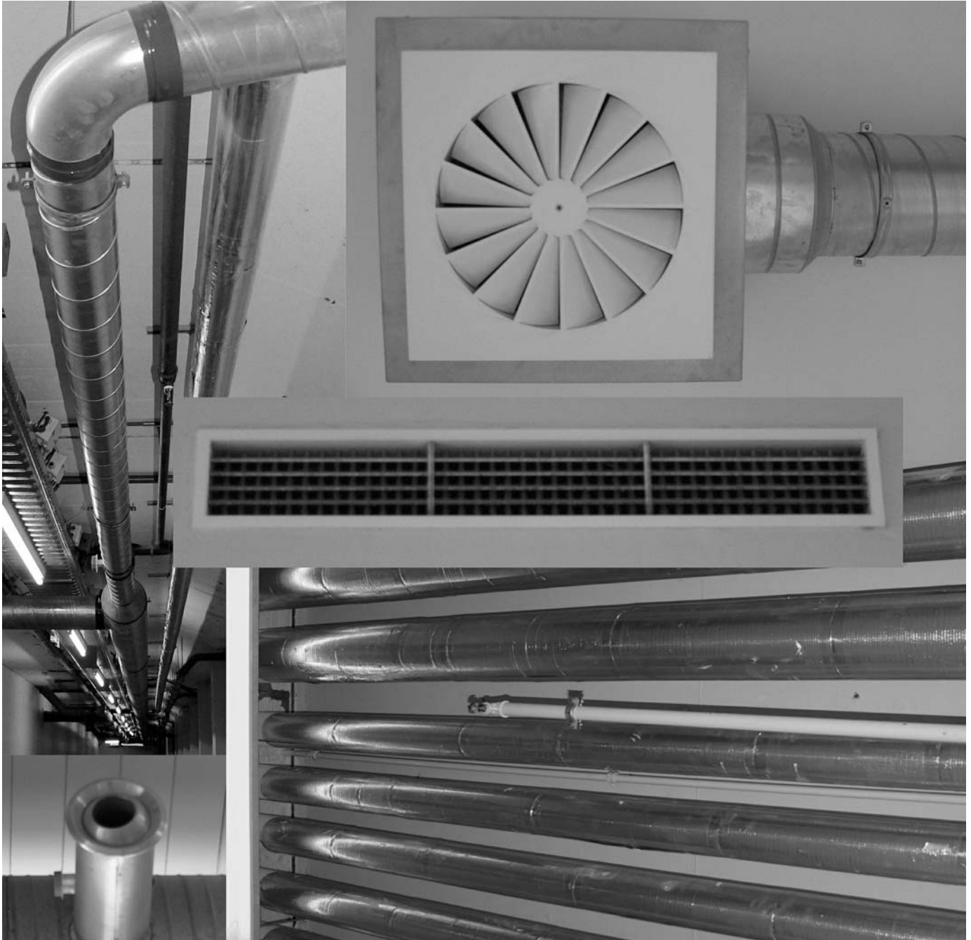
De complexiteit van luchtbehandelingsinstallaties in beeld gebracht
